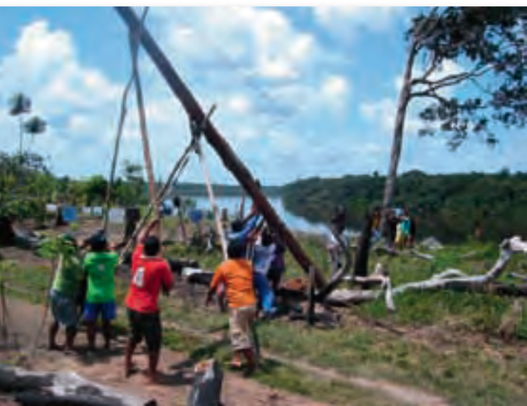
Instalação de poste para antena de radiofonia em Bacabal, Rio Aracá.
