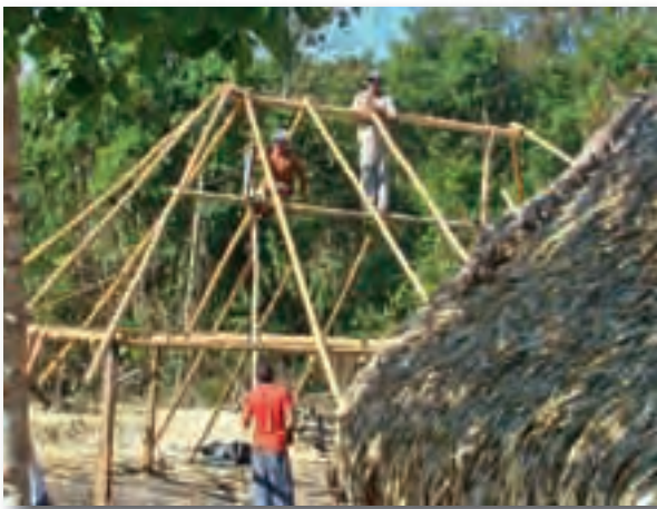
Construção de uma escolinha na localidade de Boa Saúde, Terra do Meio (PA)
